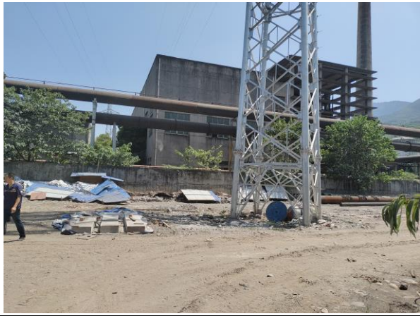
已建 110kV 魏顺 J2 铁塔（铁塔部分）
