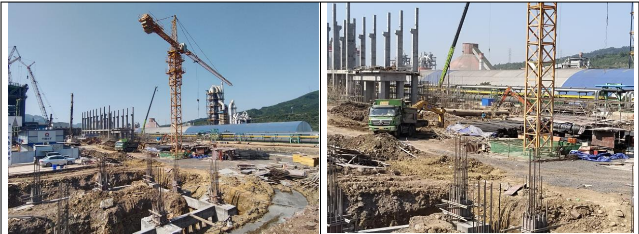
原变电站拆除后施工现场
